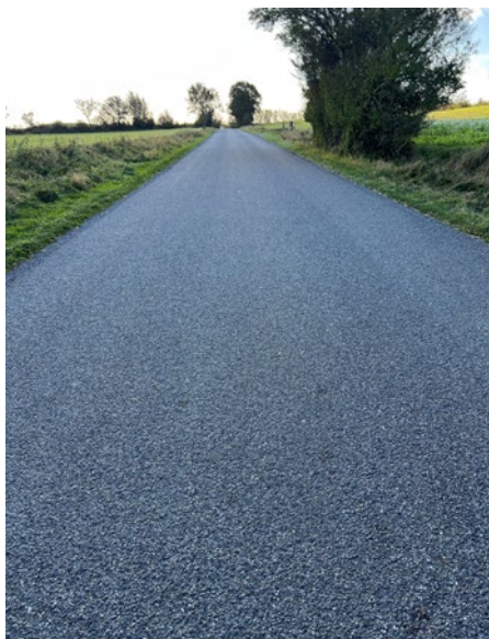
Overfladebelægning på vej i Langeland Kommune Foto: DOB
