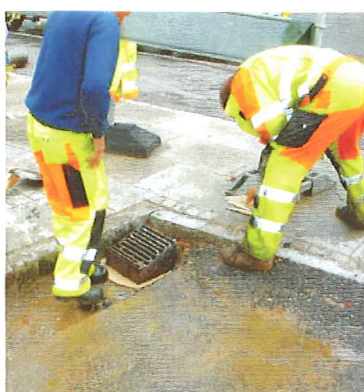
Udskiftning af brøndgods
